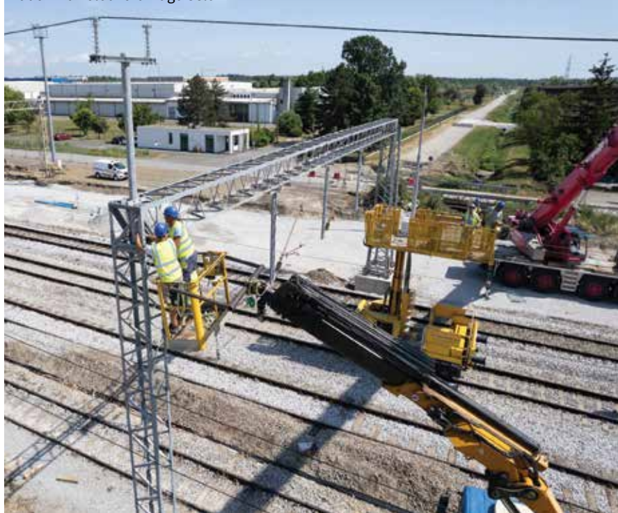
Radovi na kolodvoru Dugo Selo
